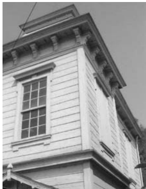
コーニス付塔屋。飾り模様のついた屋根の支え、ひさし付の上下窓。
